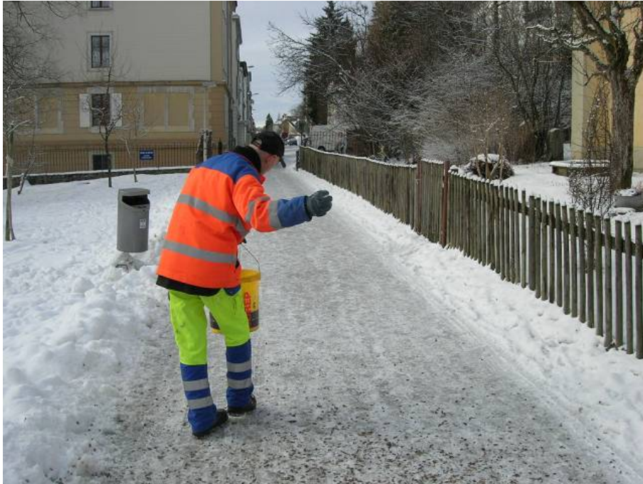
Photo 3 - Epandage à la main
